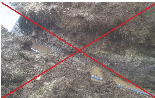
Figure 2 Tranchée profonde et large non refermée au fur et à mesure et sans mesures de contrôle de l'érosion
