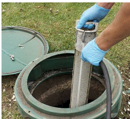
Figure 2 : Nettoyage du préfiltre
