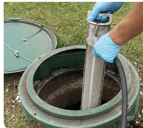
Figure 4 : Nettoyage du préfiltre
